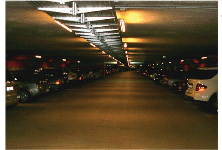
Innenansicht Tiefgarage Fürstenried West Photo: Reif
